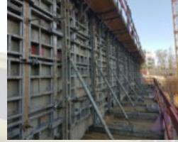
Chantier cour de justice
