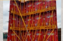
Chantier Lycée Français
