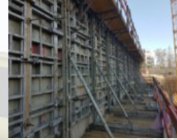
Chantier cour de justice
